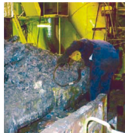
烟灰火导致的熔化
